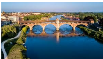
PAVIA : PONTE COPERTO
